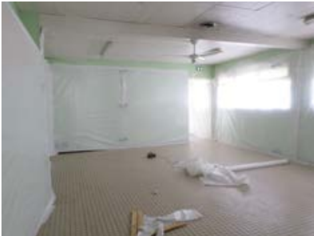
Confinement avant désamiantage.
