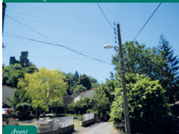
Village de COPPEL. Les travaux sont terminés.
