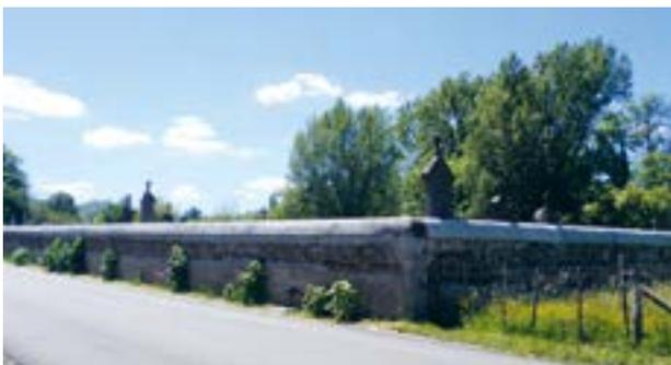
**Murs cimetière de Contournat :** Le mur d'enceinte côté nord est en très mauvais état. Des travaux de reprise des fissures ne suffiraient pas à le consolider. La commune va mandater un
