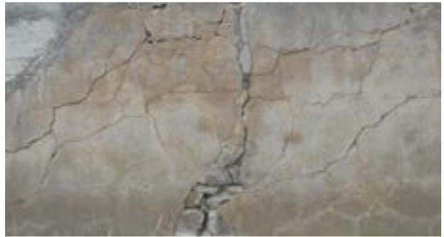
bureau d'étude structure et faire réaliser une étude géotechnique pour déterminer la meilleure formule de confortement. On peut supposer des circulations d'eau, des présences éventuelles de cavités, des assèchements au niveau des fondations. Quelle que soit la solution technique retenue, le chantier sera conséquent. Le mur est en limite de propriété et les travaux nécessiteront des accords avec les riverains.
