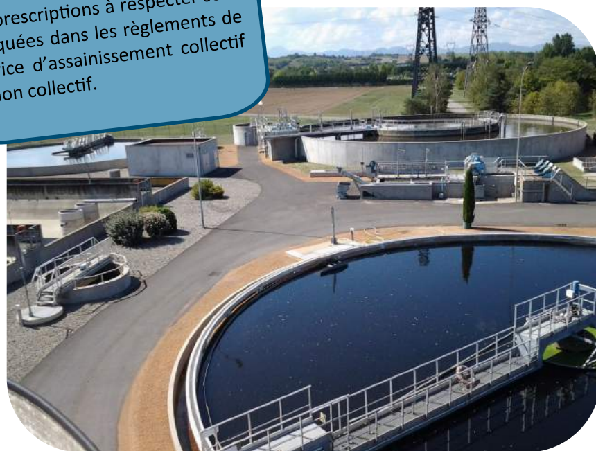
Station d'épuration des Madeleines à Pont du Château
