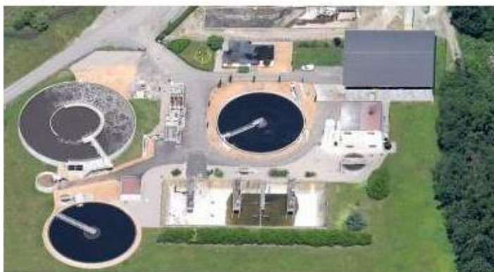
Station d'épuration de Pont du Château.
