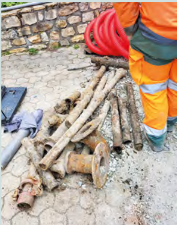
Remplacer le réseau d'eau potable n'est pas un luxe
