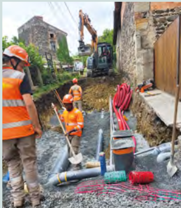
Travaux rue du Perpignan
